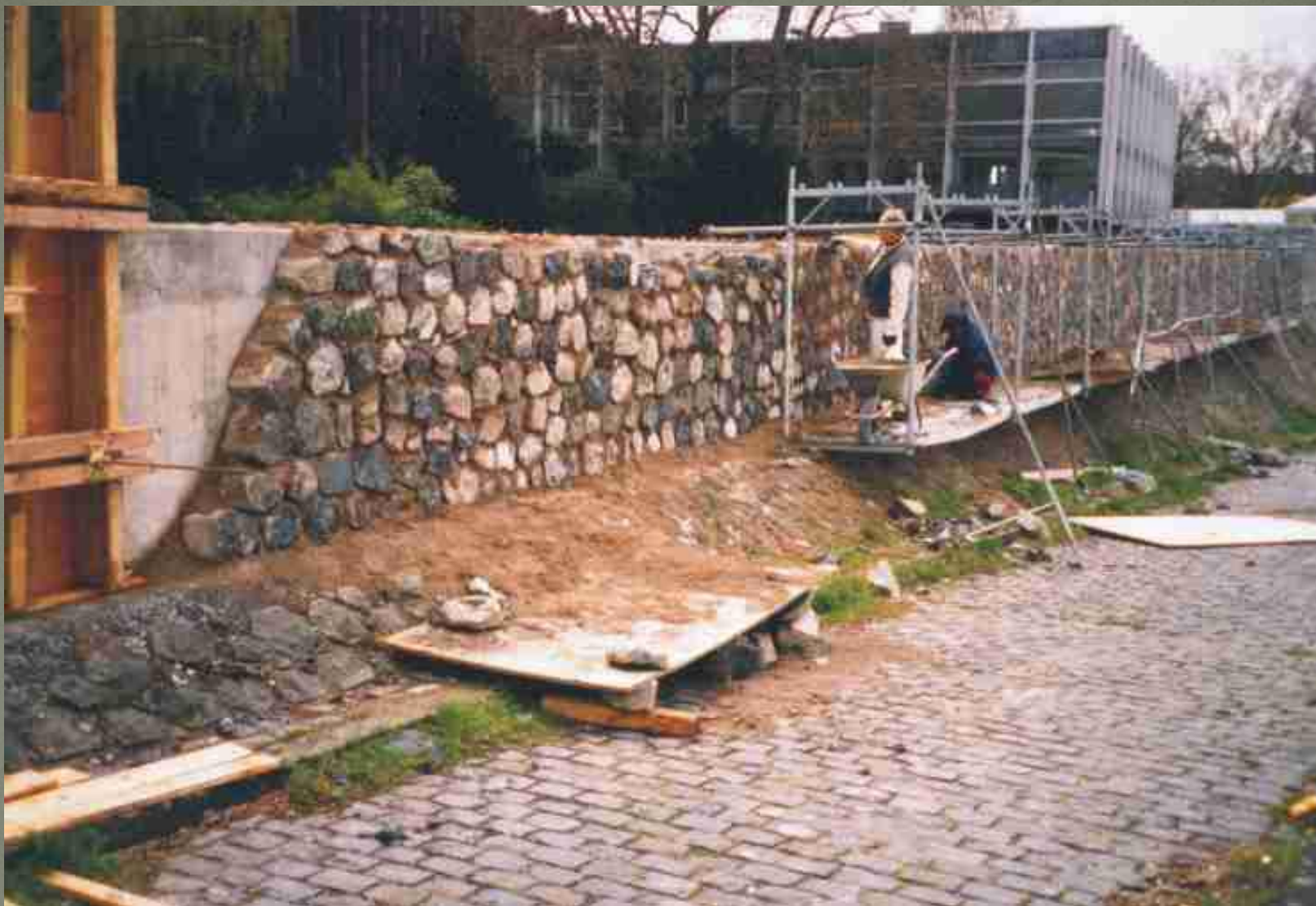
Κατασκευή προστατευτικών τοιχίων
