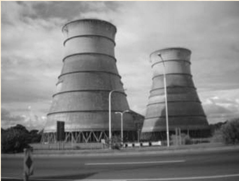
Πύργοι ψύξης φυσικής κυκλοφορίας
