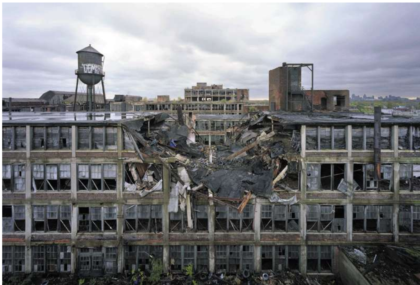
Packard Automotive Plant, East Grand Boulevard στο Ανατολικό Ντητρόιτ, 2006
