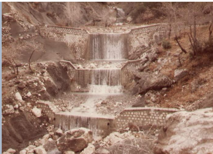
Εικ 1 Φράγματα βαθμιδωσης της κοίτης όπου επιτυγχάνεται α) Σταθεροποίηση της κεντρικής κοίτης β) Εξασφάλιση παροχетеυτικής ικανότητας
