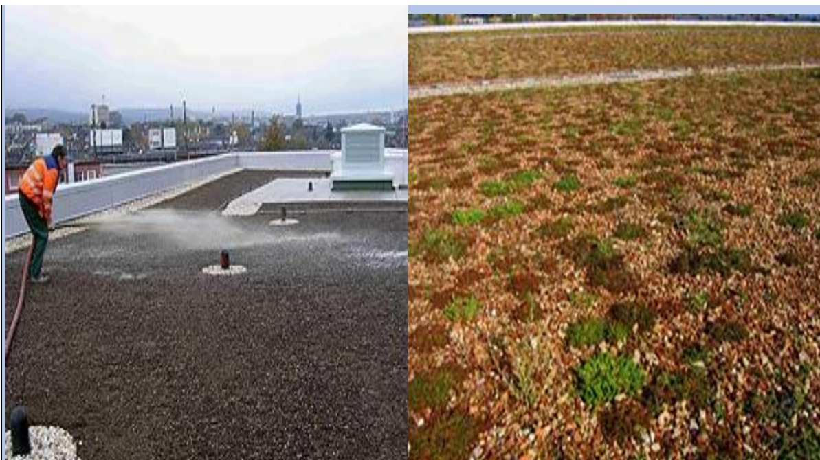
Εικ. 13 Υδροσπορά σε ταράτσα (α) έναρξη φυτρώματος σε εκτατικού τύπου πράσινη στέγη (β)
