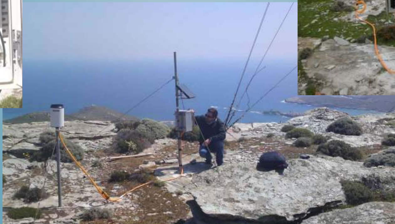
ΒΡΟΧΟΜΕΤΡΙΚΟΣ ΣΤΑΘΜΟΣ ΕΡΓΑΣΤΗΡΙΟΥ ΣΤΗΝ ΑΝΔΡΟ
