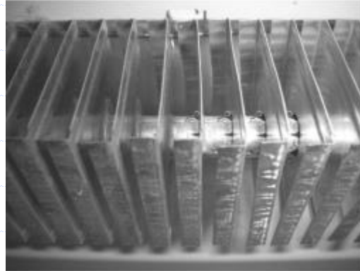
(β) Το εσωτερικό θερμαντικού επιδαπέδιου στοιχείου
