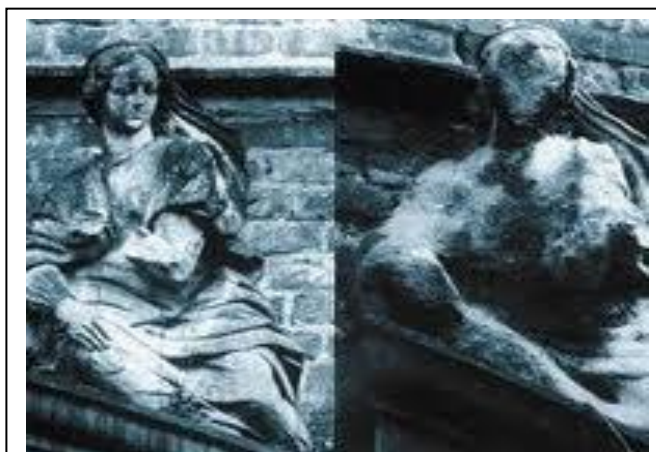
Εικόνα 2. Ένα γλυπτό στον πύργο Χέρτεν στη Βεστφαλία της Γερμανίας μοιάζει μ' ένα κομμάτι πέτρα χωρίς σχήμα. Μια φωτογραφία από το 1908 δείχνει ένα περίτεχνο άγαλμα κοριτσιού.
