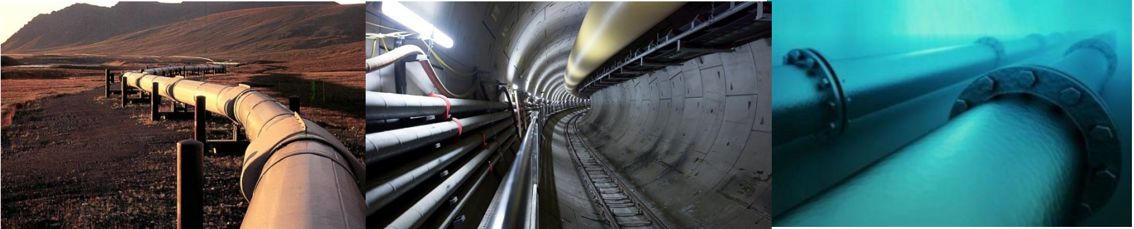
Σχήμα 1.2. Αγωγοί Μεταφοράς Φυσικού Αερίου.
